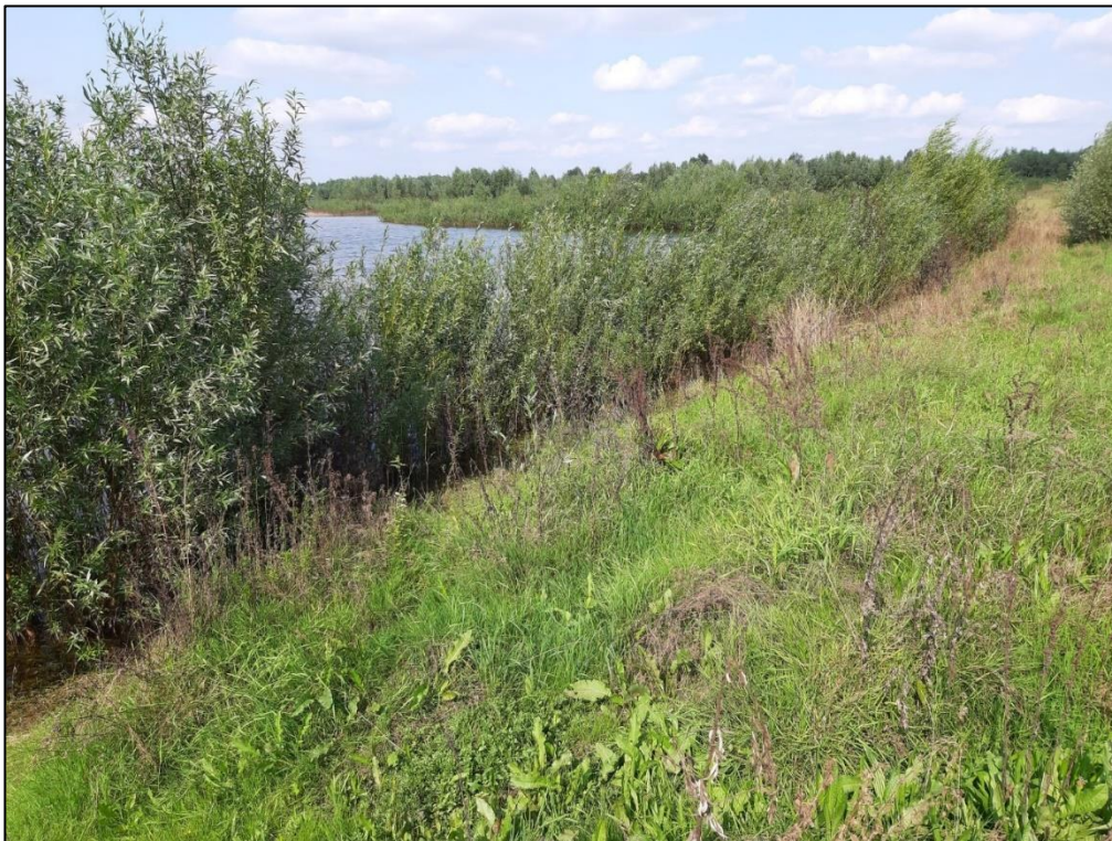
Figuur 7: Het zuiden van libellenroute 1 kijkend naar het noorden. Hier loopt het talud vrij snel op, maar verderop is een brede plas-dras zone aanwezig.
